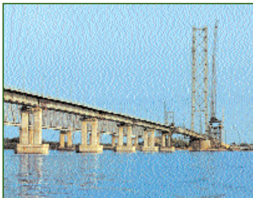
Строительство вантового моста через р. Обь (Сургут)
